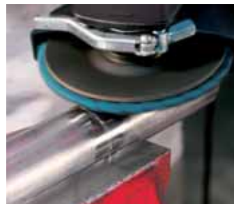
Rebarbar, trabalhos de soldadura e remoção da descoloração provocada pela soldadura.
