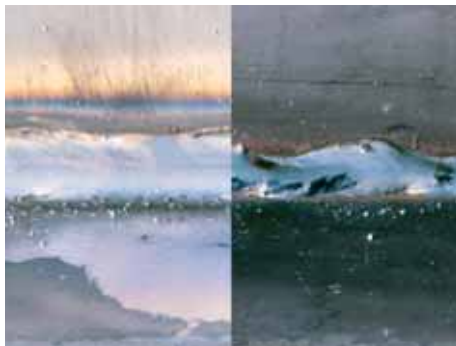
Superfície danificada depois da limpeza da soldadura (ver imagem da esquerda).
